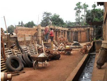
Neue Sanitär-Anlagen werden gebaut.
